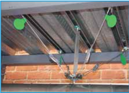
4 yönlü sismik askılama
