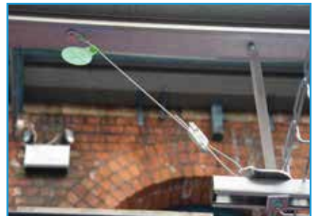
Boylamasına sismik askılama
