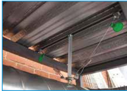
Enlemesine sismik askılama
